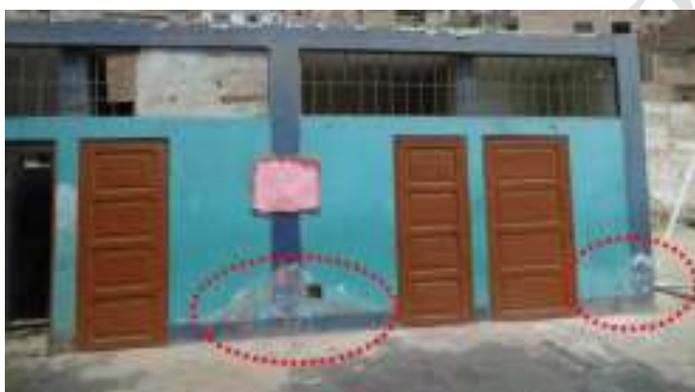
Foto: presencia de eflorescencia en el concreto de recubrimiento
