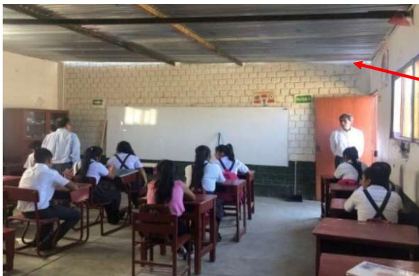
Foto: aula con muro de ladrillo sin vigas de confinamiento
