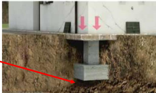
Foto: cimentación expuesta por hundimiento de suelos
