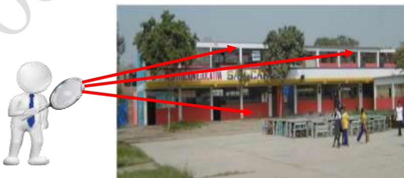
Foto: sistema estructural dual o mixto (estructura de concreto armado y muros de albañilería)-INFES.
