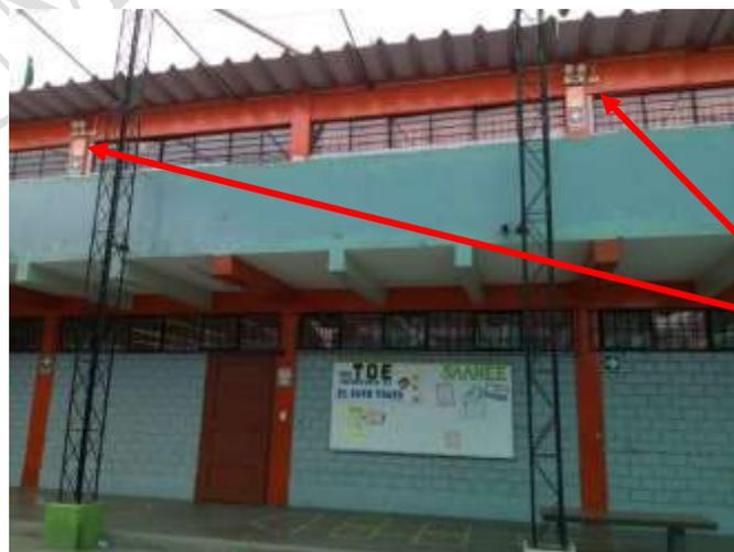
Foto: luces de emergencia en vías de evacuación
