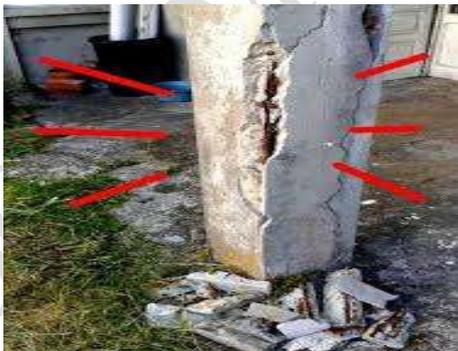
Foto: columna fracturada
