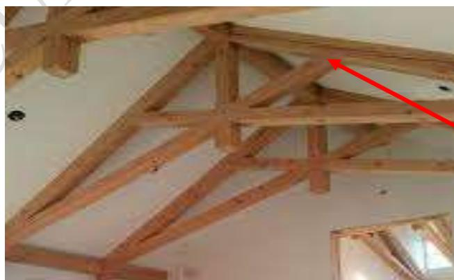
Foto: tijerales de madera en buen estado de conservación
