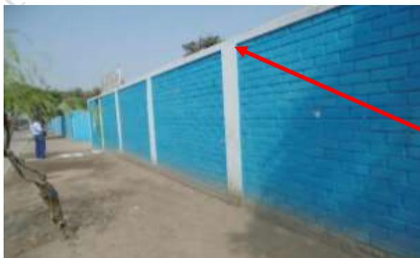
Foto: cerco perimétrico de ladrillo con viga y columna de confinamiento
