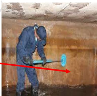
Foto: limpieza de tanque cisterna de concreto
