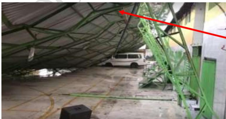
Foto: techo de estructura metálica presenta colapso total
