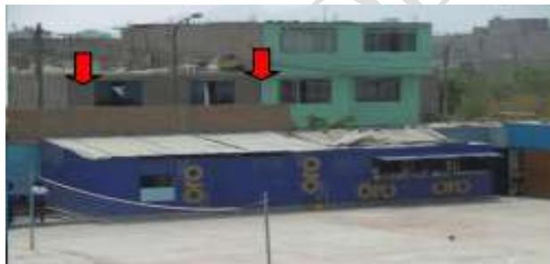
Foto: cerco perimétrico de ladrillo sin vigas de confinamiento
