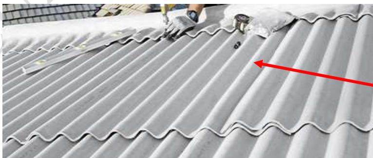
Foto: cobertura final del techo de fibrocemento
