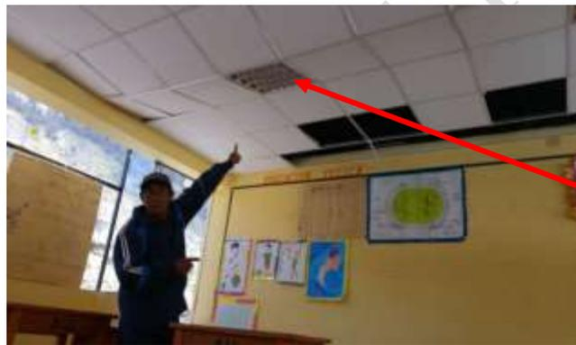
Foto: cielo raso o falso techo de aula requiere reparación
