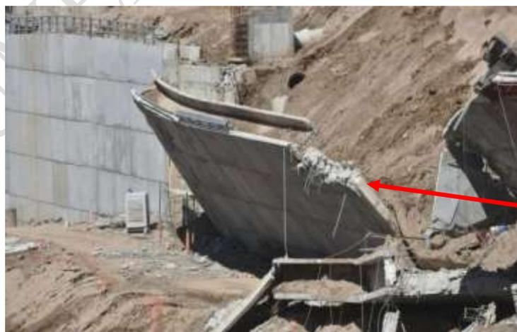
Foto: cerco perimétrico de concreto presenta daños por inclinación
