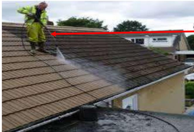
Foto: verificación del sistema de drenaje mediante surtimiento de agua con manguera
