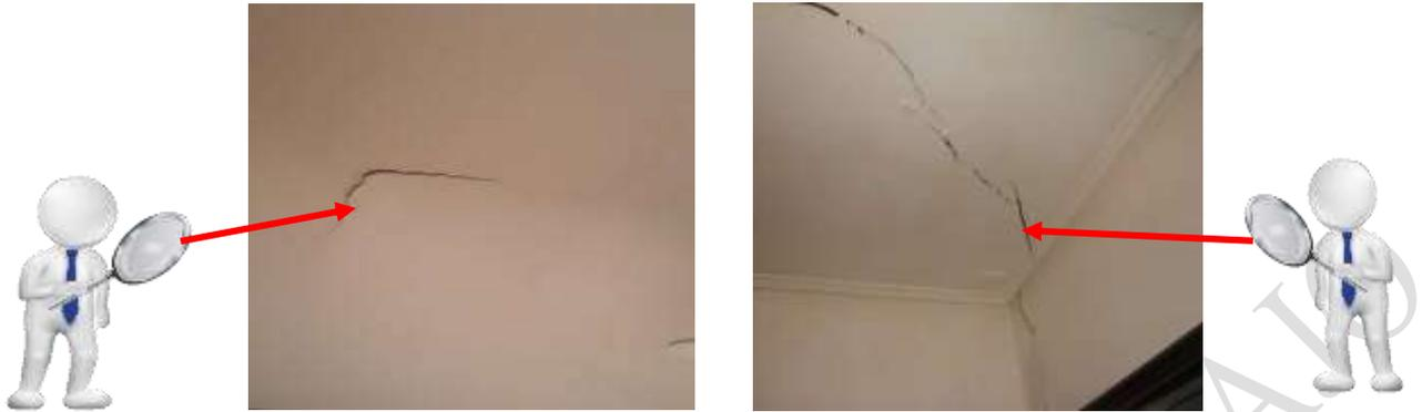
Foto: techo de concreto presenta fisuras      Foto: techo de concreto presenta grietas
