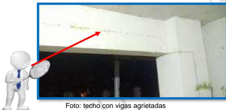
Foto: techo con vigas agrietadas
