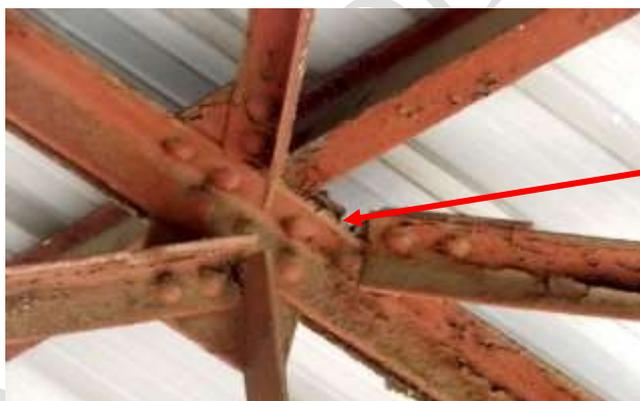
Foto: desprendimiento de nudo de estructura metálica
