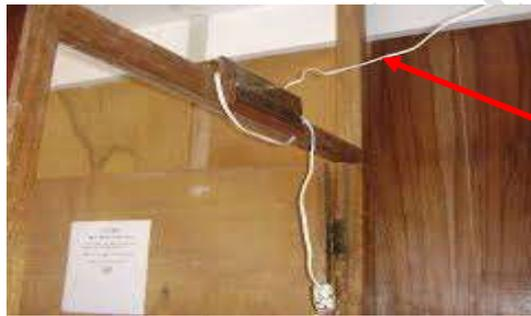
Foto : conductores flexibles (tipo mellizo)
