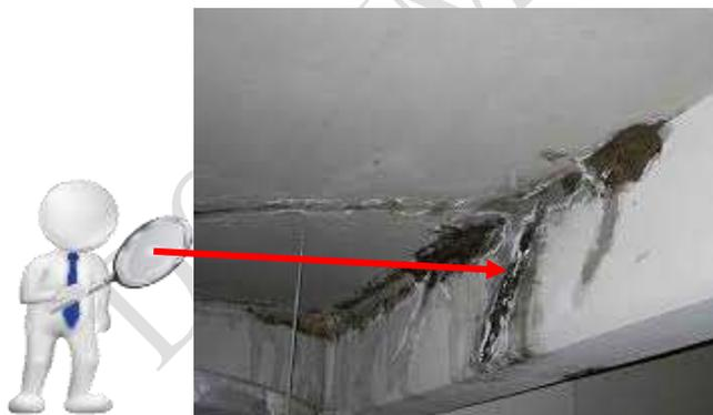
Foto: viga de concreto con deterioro por humedad
