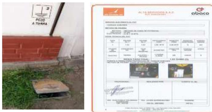
Foto: pozo a tierra presenta certificado vigente de medición de resistencia
