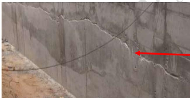
Foto: cerco perimétrico de concreto presenta fisuras
