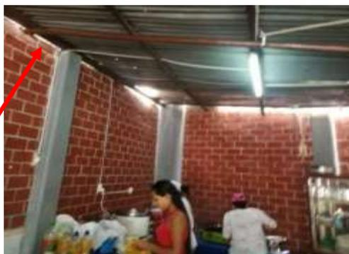
Foto: Edificación sin viga de confinamiento
