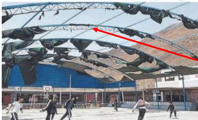
Foto: estructuras metálicas de mallas en áreas exteriores presentan óxido
