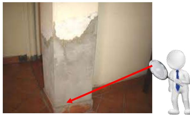
Foto: columna de concreto presenta deterioro por humedad
