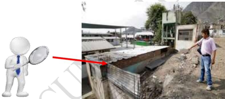
Foto: columna presenta varillas de acero expuestas a la intemperie sin recubrimiento
