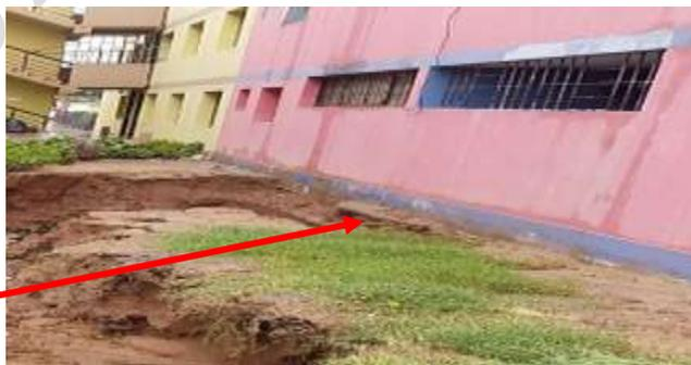
Foto: cimentación expuesta como consecuencia de la erosión por lluvias
