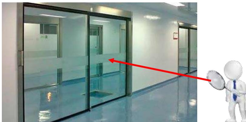
Foto: puerta de vidrio con banda señalizadora
