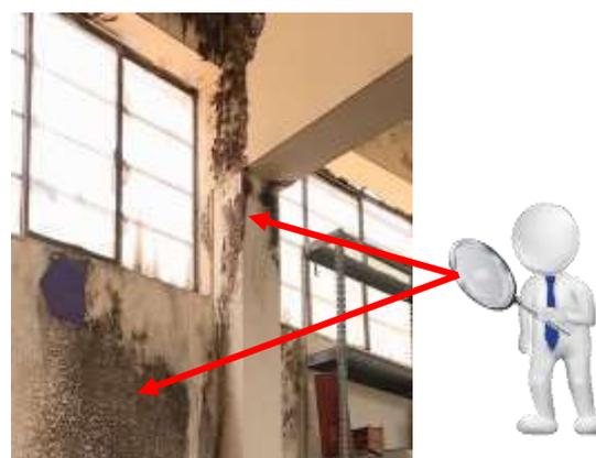
Foto: muro y columna afectado por humedad
