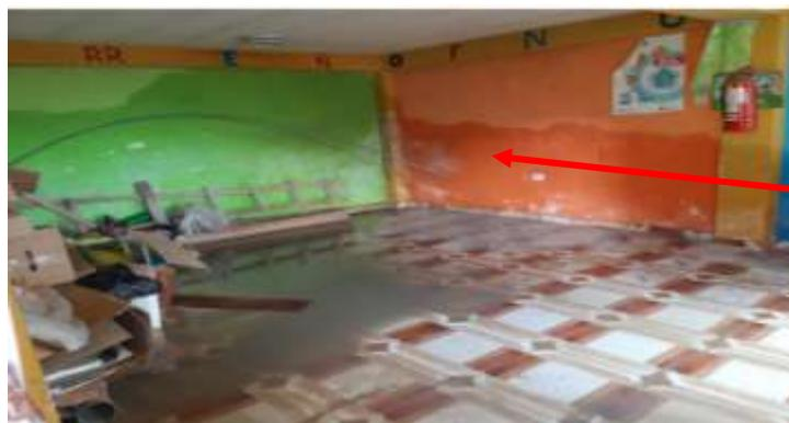
Foto: muro de ladrillo presenta daños por humedad
