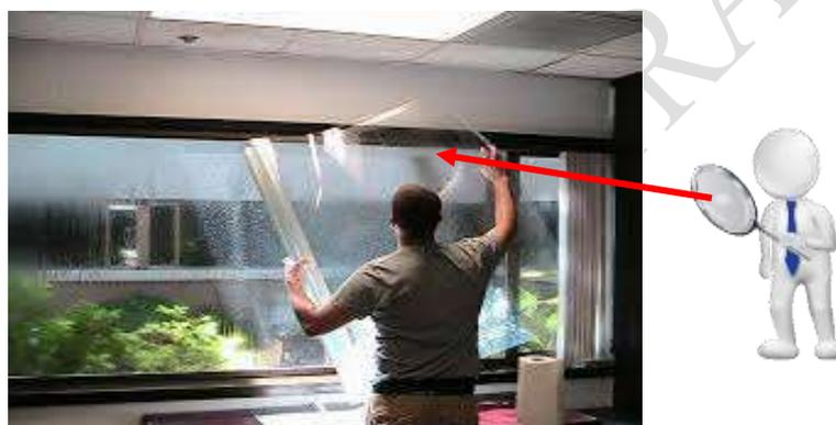
Foto: protección de superficies vidriadas con láminas de seguridad
