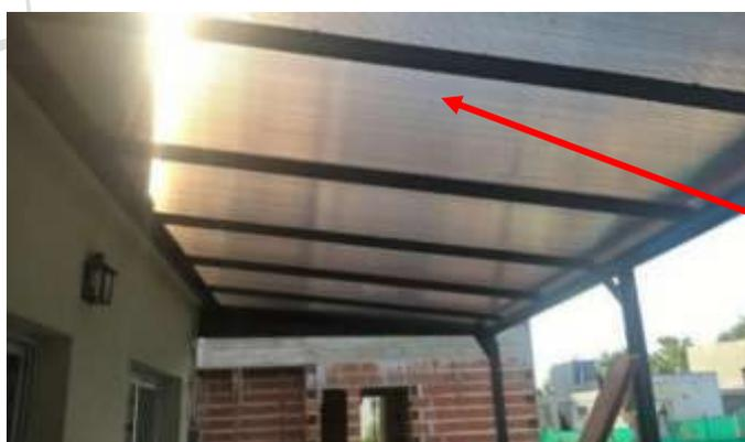
Foto: cobertura final del techo es de policarbonato
