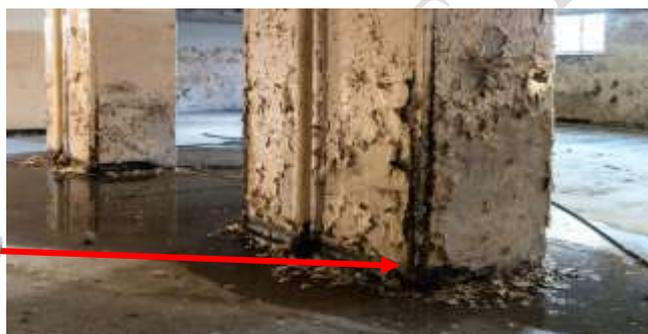
Foto: cimentación expuesta por filtraciones de agua
