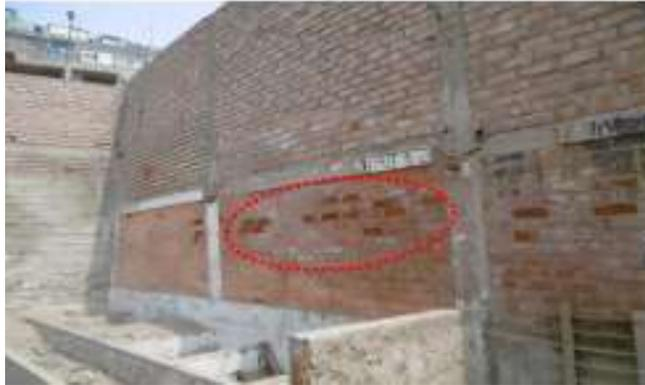
Foto: cerco perimétrico de ladrillo presenta daños por degradación de ladrillos
