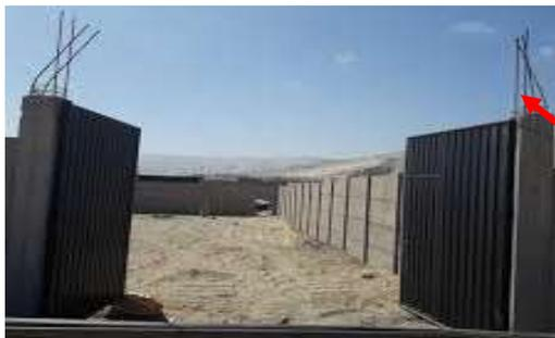
Foto: cerco perimétrico de concreto con varillas de acero expuestas
