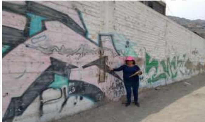
Foto: cerco perimétrico de ladrillo presenta varillas de acero expuestas a la intemperie
