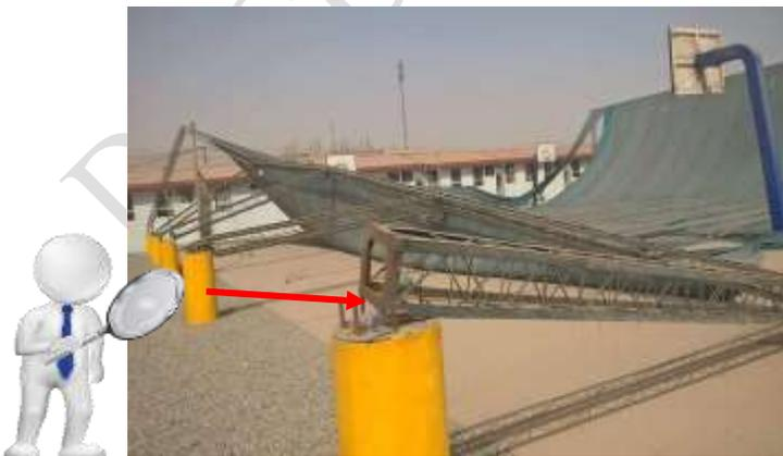
Foto: colapso de anclaje de apoyos de malla
