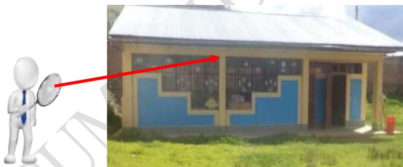
Foto: albañilería confinada con cimiento, columnas y vigas sin losa de techo
