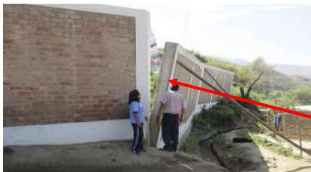
Foto: muro de ladrillo presenta daños por inclinaciones
