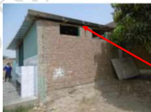
Foto: Edificación sin viga de confinamiento
