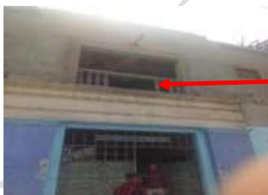
Foto: observaciones sobre deficiencias de carácter estructural (demolición de balcón) por Defensa Civil que no han sido subsanadas
