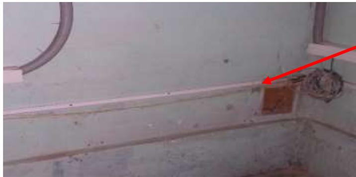
Foto : conductores eléctricos protegidos con canaletas de PVC
