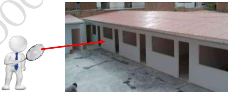
Foto: aulas de drywall con elementos prefabricados: muro de drywall o fibrocemento
