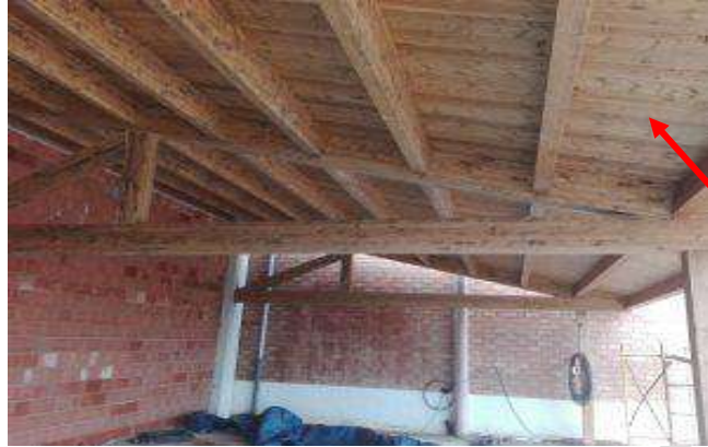
Figura N.º 90 : Techos de madera en buen estado de conservación
