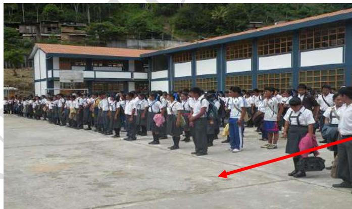
Figura N.º 152: Piso en áreas exteriores de cemento frotachado
