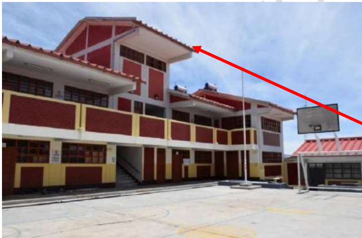
Figura N.º 136: Techo de concreto con cobertura final de calamina,
