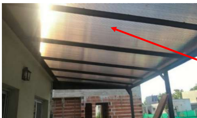
Figura N.º 141: Cobertura ligera en areas exteriores presenta buenas condiciones
