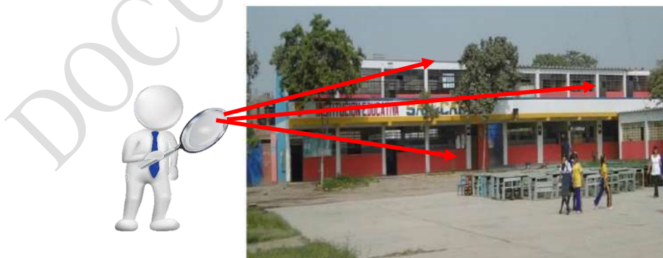
Figura N.º 5: Sistema estructural dual o mixto (estructura de concreto armado y muros de albañilería)-INFES.
