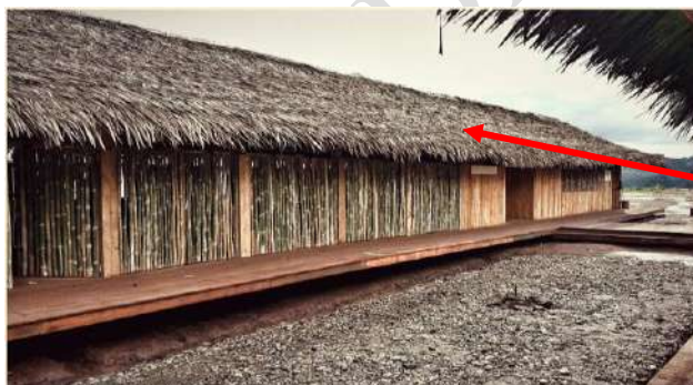
Figura N.º 140: Cobertura ligera del techo es de hojas de palmas
