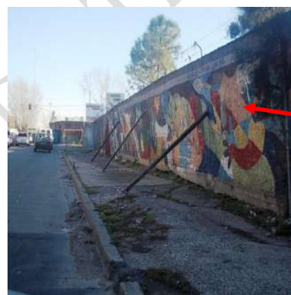
Figura N.º 26: muro inclinado
