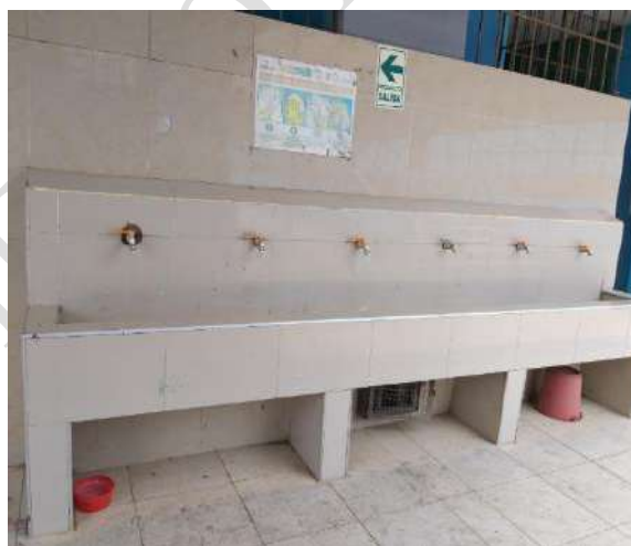
Figura N.º 174: Lavadero
