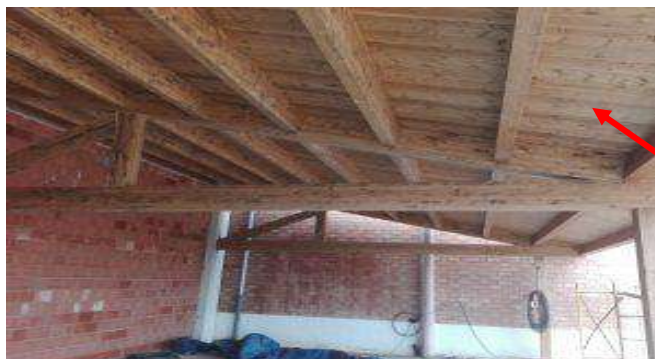
Figura N.º 139: Cobertura ligera del techo es de madera y presenta buenas condiciones
