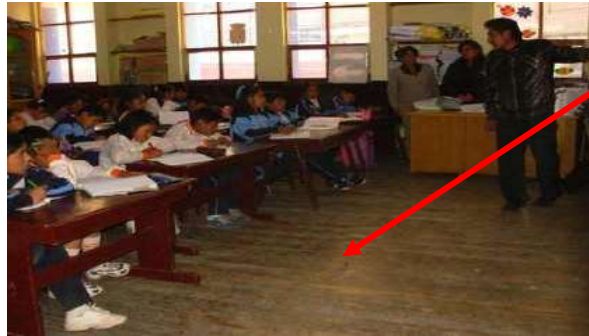
Figura N.º 117 : Piso de aula es de material antideslizante
