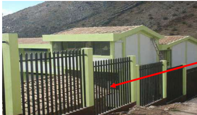
Figura N.º 108: Cerco perimétrico metálico en buen estado de conservación
