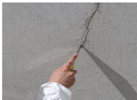
Figura N.º 27: Encuentro de muros con grietas
