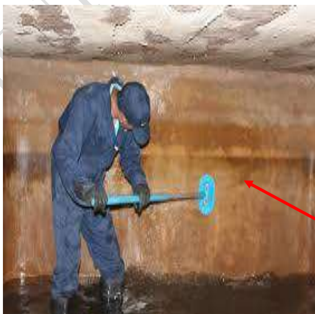
Figura N.º 190: Limpieza de tanque cisterna de concreto
