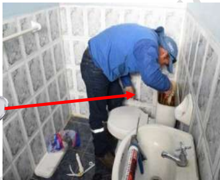
Figura N.º 169: Reparación de cañería por fuga de agua
