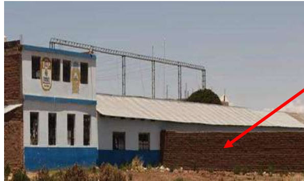
Figura N.º 105: Cerco `perimétrico de adobe no presenta daños
