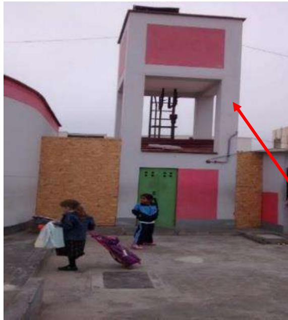
Figura N.º 191: Tanque cisterna de concreto
