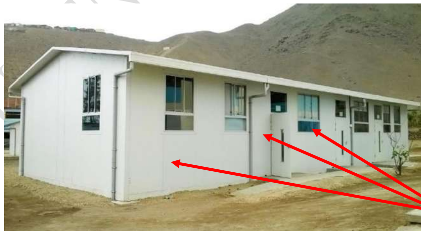
Figura N.º 79: Módulo prefabricado en buen estado de conservación
