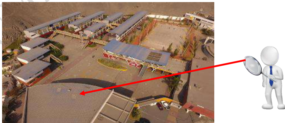
Figura N.º 76: Techo de estructura metàlica no presenta deterioro
