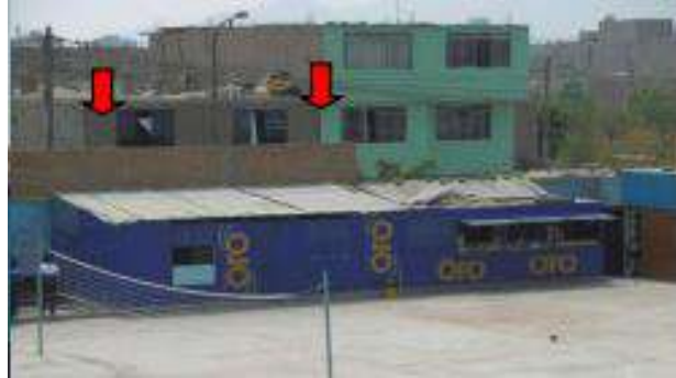
Figura N.º 103: Cerco perimétrico de ladrillo con viga y columna de confinamiento
