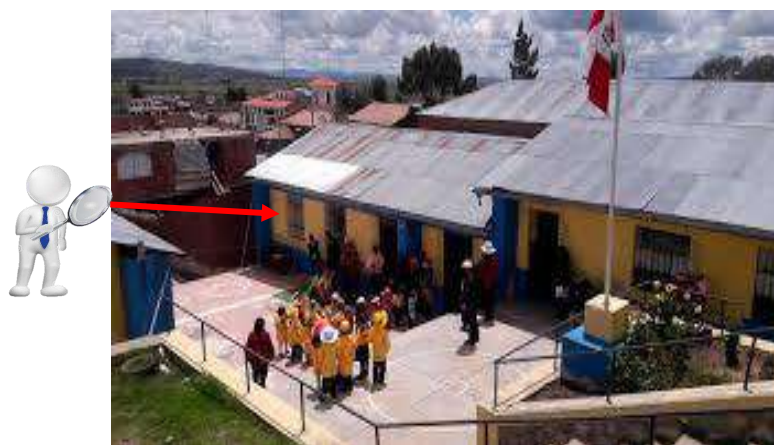
Figura N.º 12: Edificación de sistema estructural de adobe
