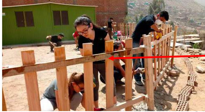
Figura N.º 110 :Instalación de cerco perimétrico de madera
