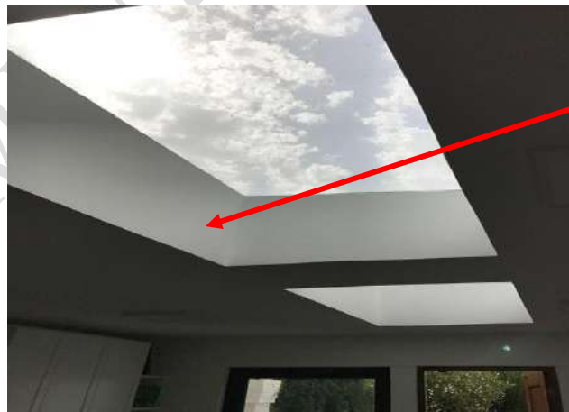
Figura N.º 120: Aberturas al exterior con parapetos
