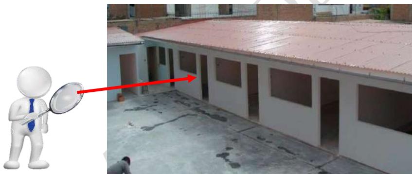
Figura N.º 15: Aulas de drywall con elementos prefabricados: muro de drywall o fibrocemento
