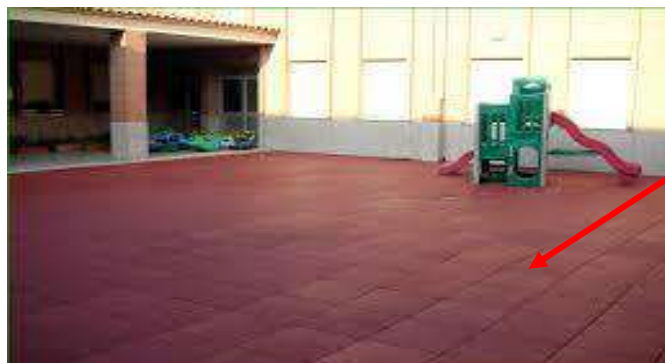
Figura N.º 151: Piso de caucho de exteriores en buen estado de conservación
