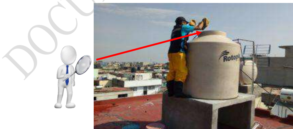
Figura N.º 188: Limpieza del tanque elevado
