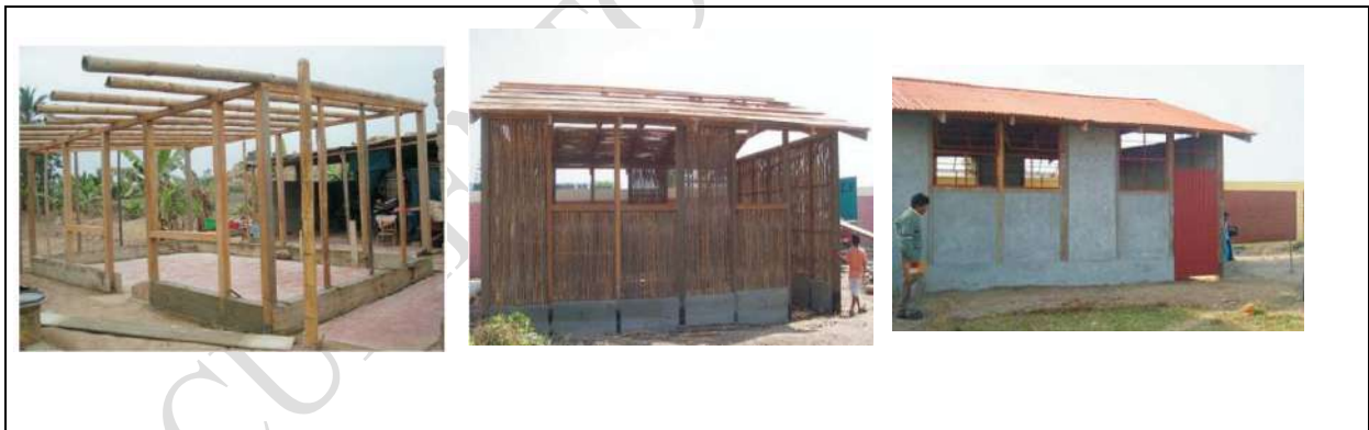
Figura N.º 20: Proceso de construcción - aula de quincha mejorada
