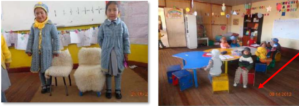
Figura N.º 154: Pisos de aulas con machihembrado de madera
