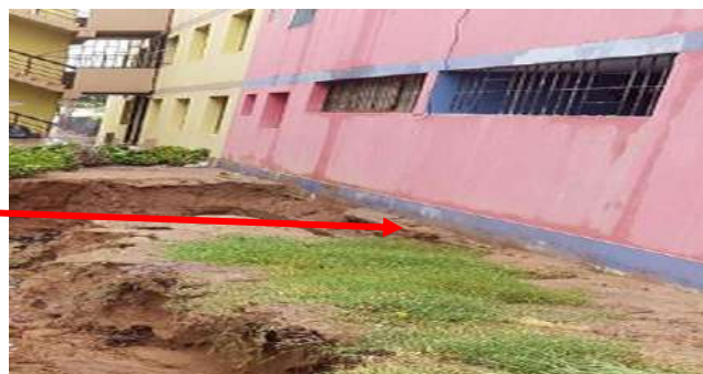
Figura N.º 40: Cimentación expuesta como consecuencia de la erosión por lluvias
