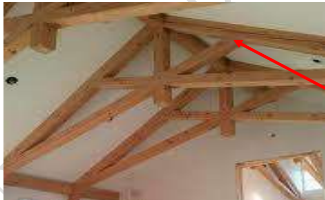
Figura N.º 91 : Tijerales de madera en buen estado de conservación
