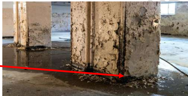
Figura N.º 39: Cimentación expuesta por filtraciones de agua
