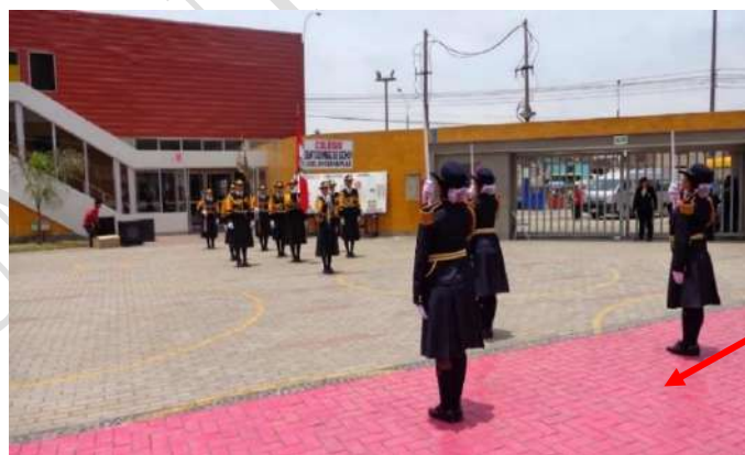
Figura N.º 150: Piso de adoquín en áreas exteriores en buen estado de conservación
