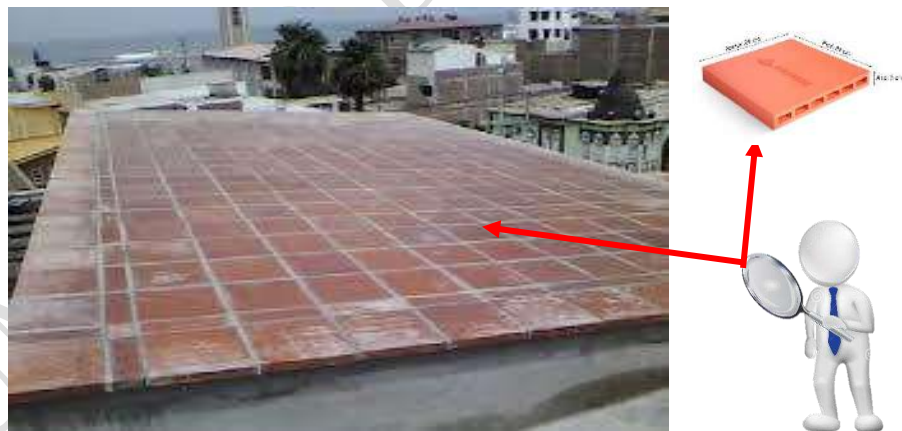
Figura N.º 134: Techo de concreto con cobertura final de ladrillo pastelero
