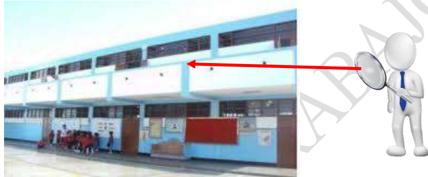
Figura N.º 68: Parapeto cuenta con elementos de confinamiento
