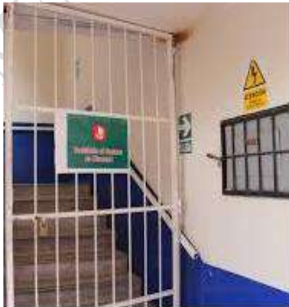
Figura N.º 203: iluminación general en tablero eléctrico
