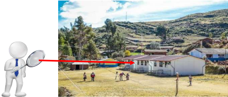
Figura N.º 14: Módulos prefabricados con paneles metálicos
