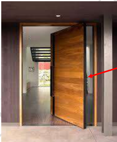
Figura N.º 118: Puerta del local educativo gira 180 grados
