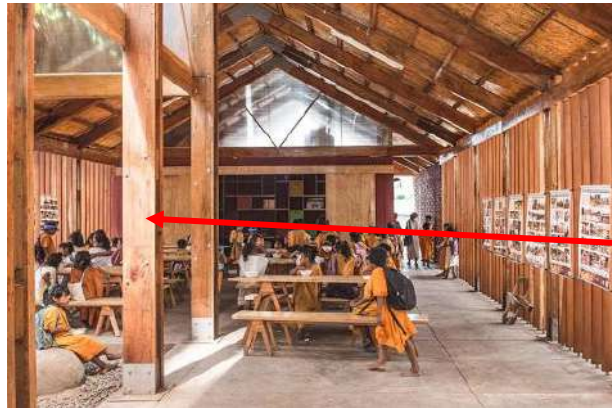
Figura N.º 85: Columnas de madera en buen estado de conservación
