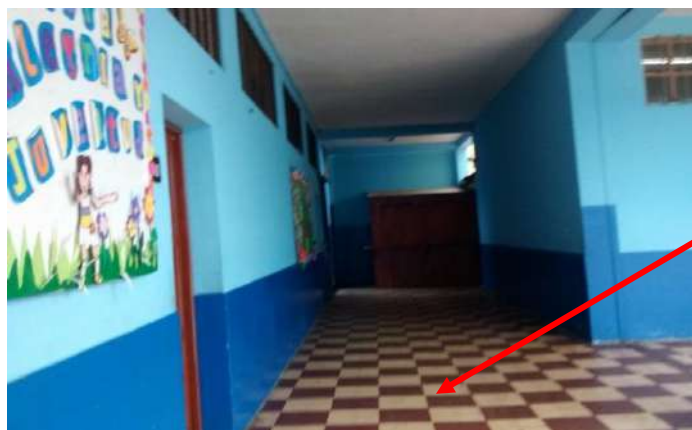
Figura N.º 149: Piso de loseta antideslizante en áreas exteriores
