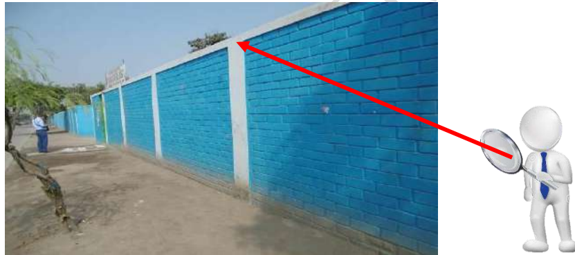
Figura N.º 103: Cerco perimétrico de ladrillo con viga y columna de confinamiento
