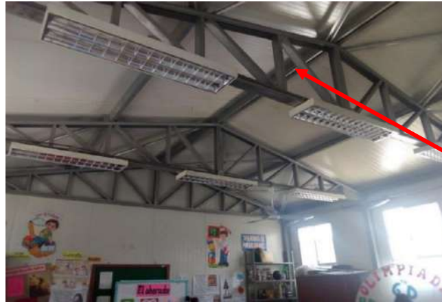
Figura N.º 77: Tijerales en buen estado de conservación
