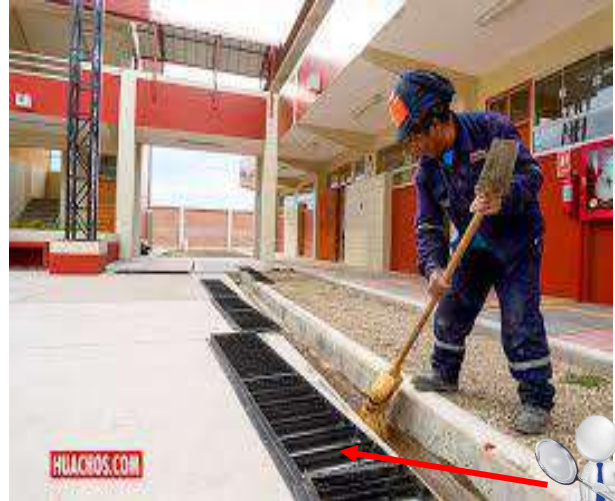
Figura N.º 183: Cunetas
