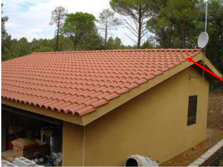
Figura N.º 135: Techo de concreto con cobertura final de tejas de arcilla
