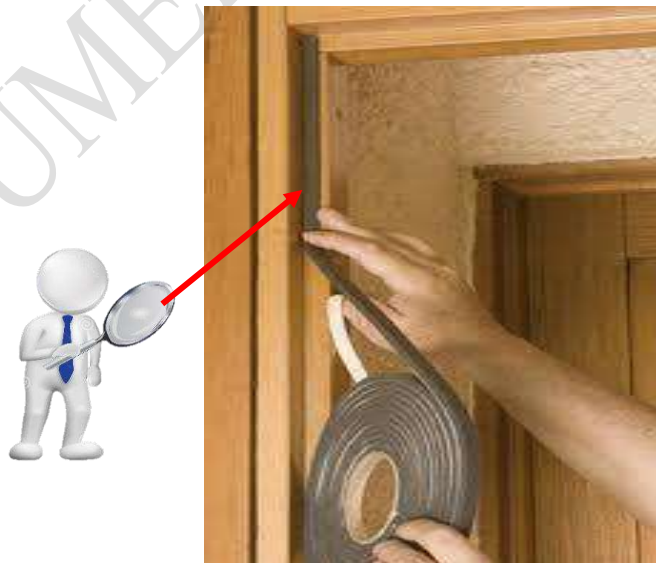
Figura N.º 157: Sellado térmico de puerta
