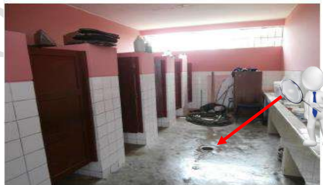
Figura N.º 184: sumidero en servicio higiénico
