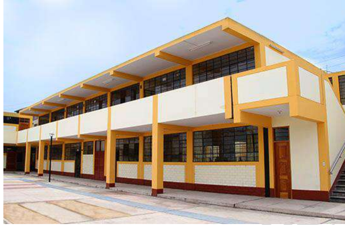
Figura N.º 142: Techo de losa aligerada sin cobertura final para protección ante lluvias
