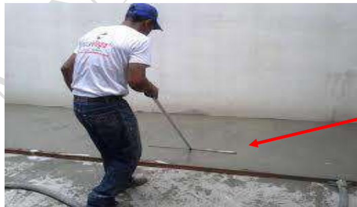
Figura N.º 146: Reparación de piso de cemento
