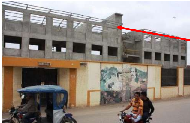
Figura N.º 36: Local educativo remodelado
