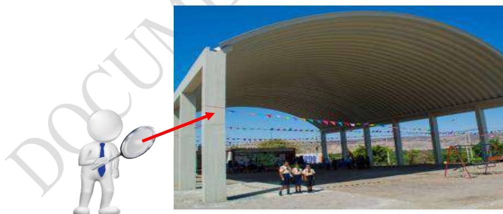
Figura N.º 13: Estructura metálica de local educativo
