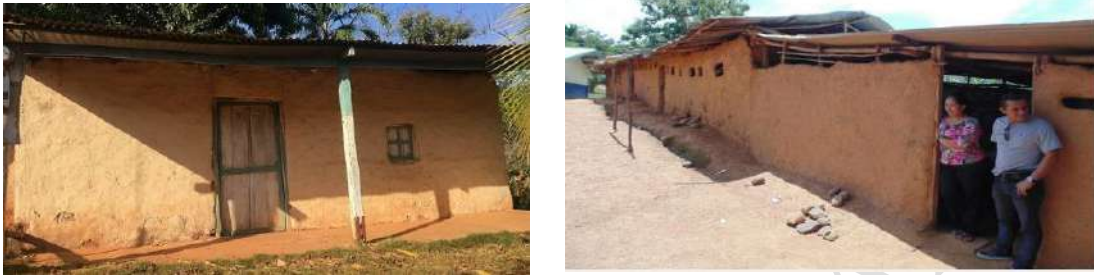
Figura N.º 19: Aulas de quincha tradicional
