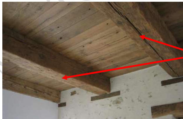
Figura N.º 86: Vigas de madera en buen estado de conservación
