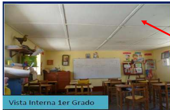
Figura N.º 153 : Cielo raso horizontal en aula
