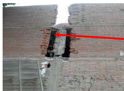
Figura N.º 28: Encuentros de columna separados
