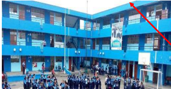
Figura N.º 60: Edificación de albañilería confinada con techo de losa aligerada
