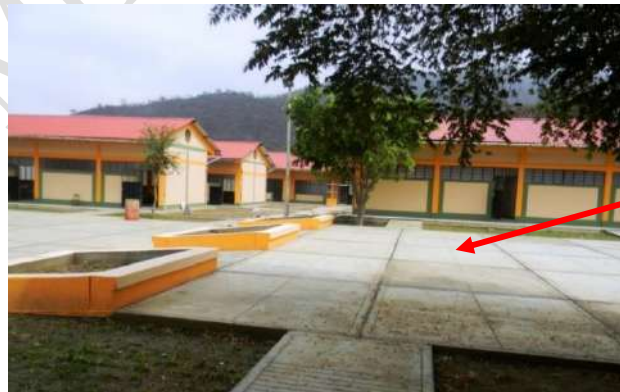
Figura N.º 116 : Pasadizos, accesos se encuentran libres de obstáculos
