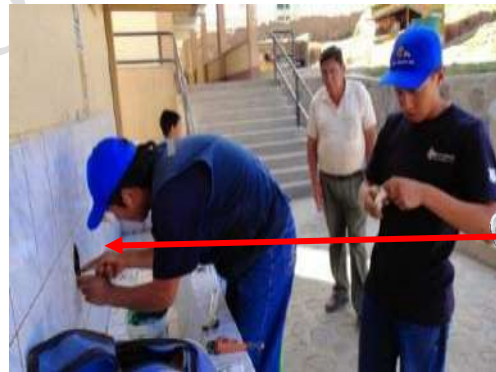
Figura N.º 169: Reparación de cañería por fuga de agua
