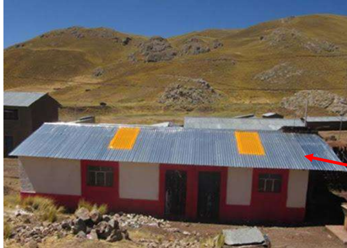
Figura N.º 137: Cobertura ligera de calamina en buenas condiciones
