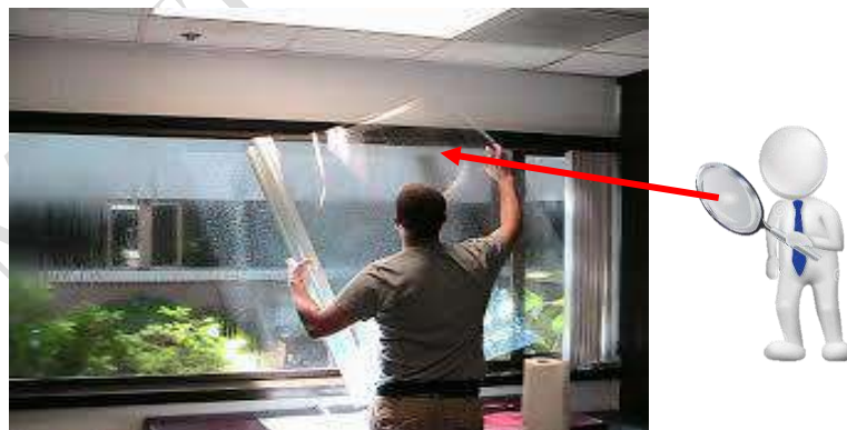
Figura N.º 122: protección de superficies vidriadas con láminas de seguridad
